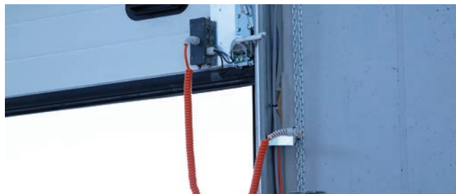
Dispositivo di sicurezza per rottura del cavo o delle molle
